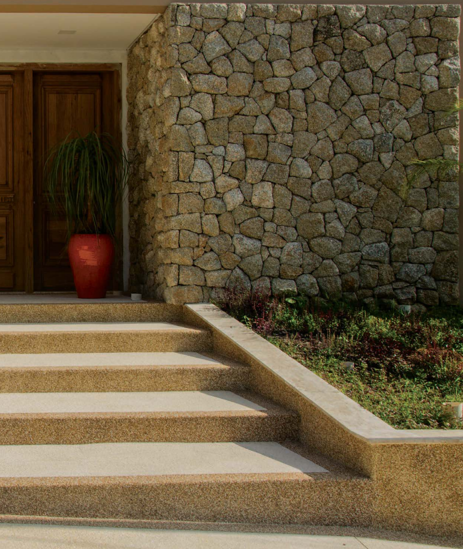
Revestimento do Muro em Pedra Moledo
